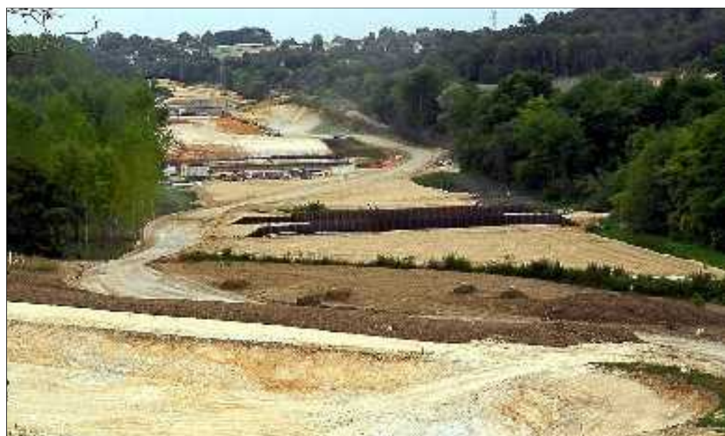
TROUÉE VERS LE SUD. Cette photo représente une partie de la tranchée, sur environ 2 km (le tiers du tracé total), tournée vers le sud (vers la Loire), ce qui permet de voir le gigantisme du chantier. Au fond, on voit le passage supérieur du bief de Bois-Jésus. Sur les côtés, les rideaux d'arbres restent denses : la vallée de la Choisille est un espace très vert. Évidemment, ce n'est pas l'idéal d'y faire passer un périphérique. A gauche au premier plan, on aperçoit un bassin de traitement des eaux usées (situé sur la commune de Saint-Cyr). Au centre, la voie aménagée pour les camions et autres véhicules de chantier, voie qui zigzague le long du tracé.
