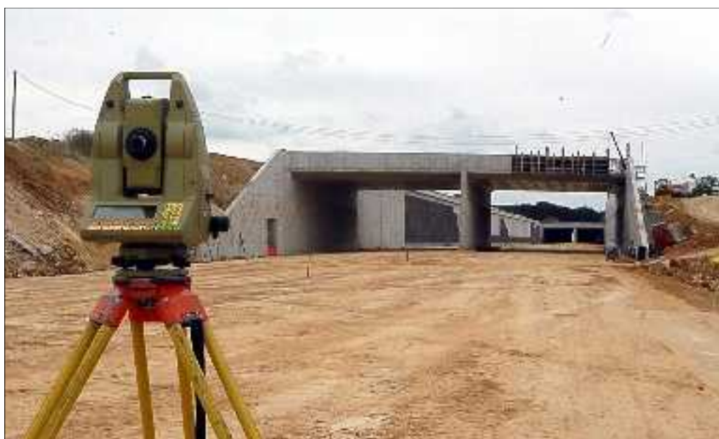
CARREFOUR DE LA ROUTE DU MANS. On arrive là à l'autre extrémité du tracé, côté La Membrolle-sur-Choisille et les hauts de Saint-Cyr, au niveau des deux giratoires de la route du Mans et d'Angers, non loin du Auchan. On aperçoit au fond la partie couverte sur 300 m (qui n'est pas un tunnel mais une tranchée couverte qui sera végétalisée en surface, pour éviter les nuisances sonores), la partie découverte, et au premier plan le petit pont de la Voie romaine (pavé un peu plus loin). La version tunnel n'a pas été retenue pour des raisons de coût, et ne s'imposait pas. Le périphérique vient buter là, jusqu'à nouvel ordre, car la partie est (du côté de Notre-Dame-d'Oé) n'a pas encore été négociée.
