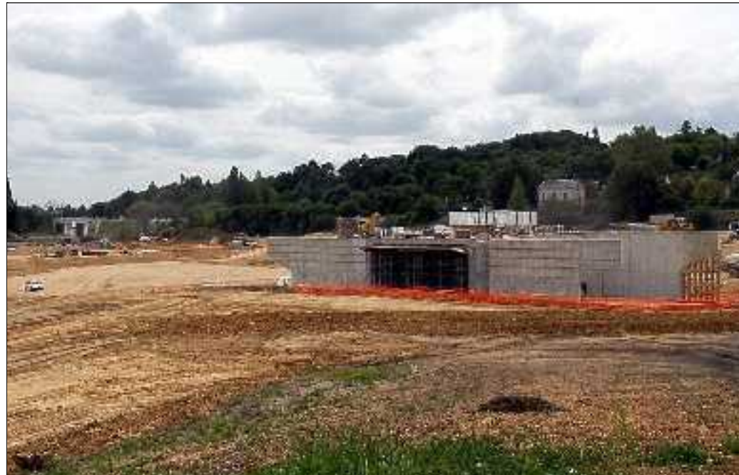
GARE DE FONDETTES. Au point le plus bas, sur Fondettes, près de la levée de la Loire, là où il y avait autrefois l'entreprise Poirier, au niveau de l'ancienne gare (que l'on voit au centre, au fond), des friches et jardins SNCF (près de la ligne Tours - Le Mans encore en fonction), le terrain a été creusé de 2,50 m. Deux giratoires y sont prévus, sur un espace de 4 à 5 ha. Spectaculaire ! Un peu plus loin en amont, une zone de compensation des crues a été aménagée dans d'anciens champs de blé et maïs, espace naturel sensible : la prairie sera inondable (l'eau s'écoulera par un chenal jusqu'à la Choisille), et ouverte aux moutons du lycée agricole voisin le reste du temps. Les bonnes et mauvaises terres sont triées pour être exploitées au mieux, sur place, intégralement.
