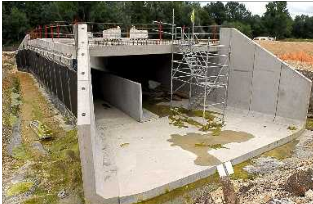
BIEF DE BOIS-JÉSUS. Dans cette zone de la Choisille, charmante petite rivière, il y a encore des moulins. Les biefs hachés par le chantier sont refaits à ciel ouvert, et même sous le périphérique comme on le voit sur cette photo. Les piétons passeront sur la gauche, l'eau sur la droite. Le but est de préserver au mieux l'écosystème local. Au fond, on aperçoit des peupliers dont beaucoup n'ont plus de valeur car elles ont été détruites, et pas entretenues, par les tempêtes de 1999 et 2003. A noter que les parois des ponts et autres équipements sont recouverts de motifs en béton qui représentent des herbes hautes. Il y a peu de riverains, de maisons, le long de cette tranchée ouverte maintenant sur toute la longueur du tracé.
