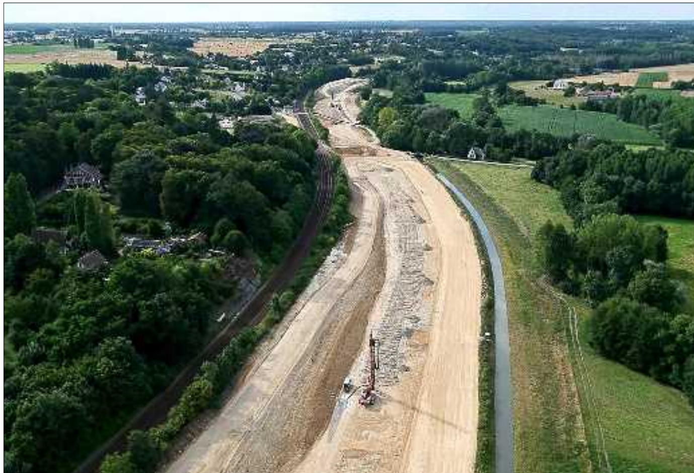
Vue aérienne (par ballon) d'une grande partie du tracé du périphérique de Tours-Nord-Ouest. L'accès au public y est interdit mais la NR a pu, pour la première fois, remonter la totalité du tracé.
